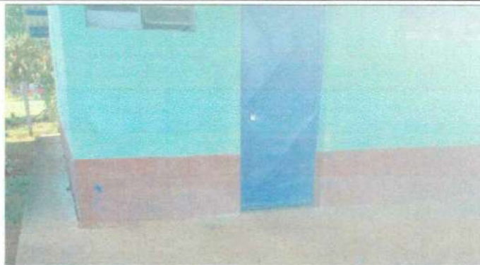
Foto 2: PINTURA EN MURO EXTERIOR E INTERIOR
