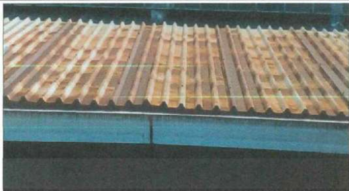
Foto1: SUSTITUCION DE LAMINA DETERIORADA POR LAMINA TROQUELADA
